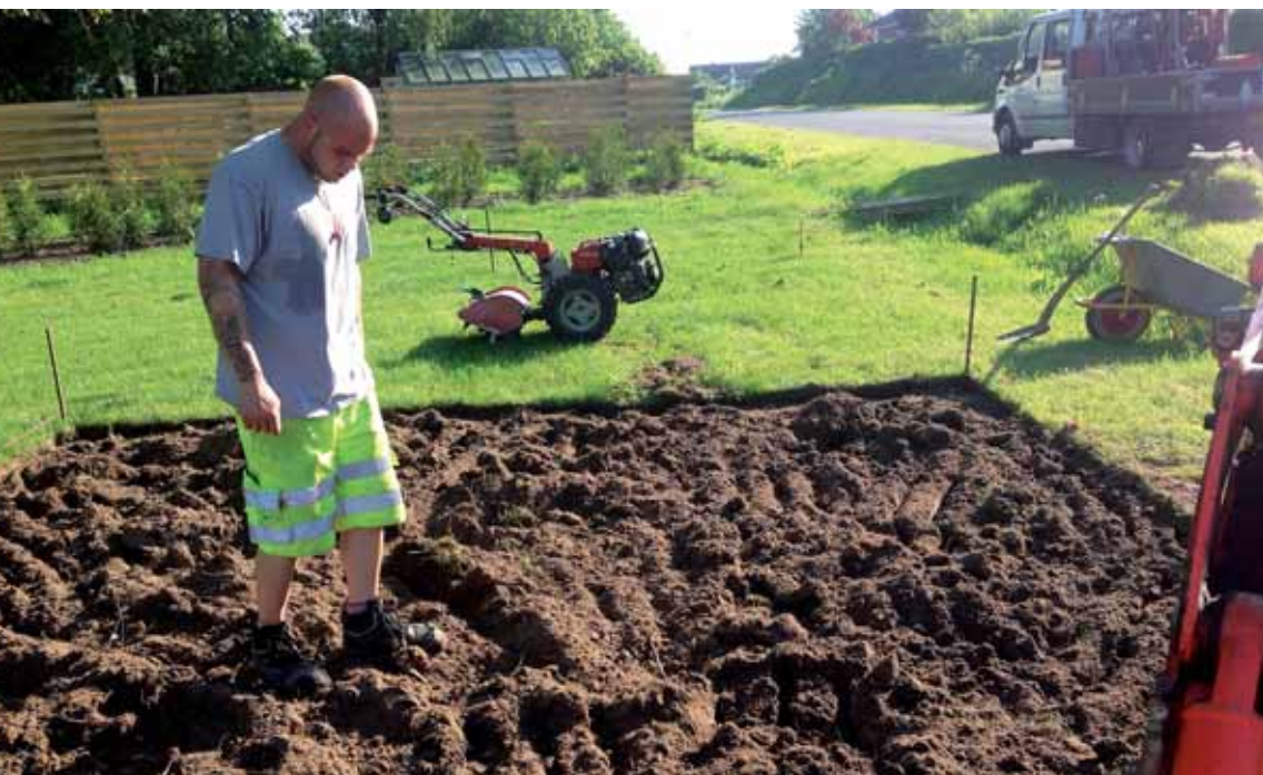
Ansgar Anlæg er ved at gennemgå en omfattende renovering som er rene ekstraarbejder for entreprenøren Ribergaard Anlægsgartnere der har tre af Odense Kommunes fem gartnerentrepriser. På billedet er folkene ved at sætte stålkanterne som skal ramme det nye staudebed ind. Foto: Odense Kommune.
