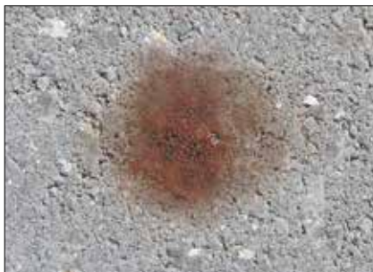
Lader man fugegrus henligge på belægningen, risikerer man afsmitninger, der i værste fald bliver bundet af kalkudfældninger.
