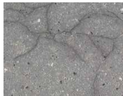
Eksempel på alkalikiselreaktioner, også kaldet "spindelvæv".
